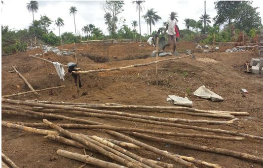
Helfer beim Abstecken des Baugrundstücks für das PADC und Ausheben der Fundamente
