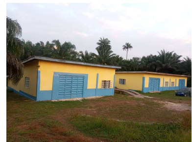
Zwei Werkstattgebäude, dazwischen die Montagerampe der Kfz-Werkstatt
