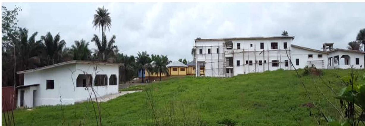
Seitenansicht des Hauptgebäudes, vorne links das Gebäude der Abteilung Maurer-/Betonarbeiten und Klempnerei, im Hintergrund die Gebäude der Landwirtschaftsabteilung - Februar 2020
