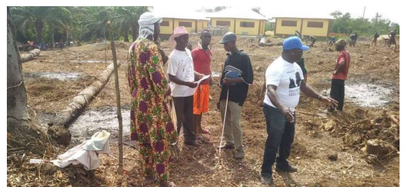
Freilegen des Baugeländes - Dezember 2018
