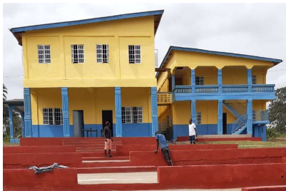
Das zweiflügelige Hauptgebäude mit Veranstaltungsfläche im Vordergrund
