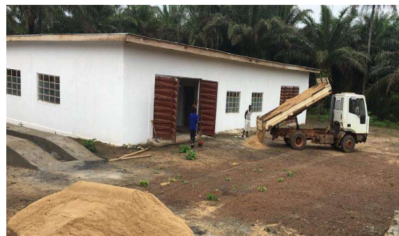
PYDs Kipper-Lkw liefert Sand an der Baustelle - Okt. 2019
