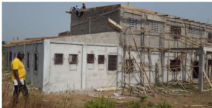
Bau des Dachs auf dem Obergeschoss - November 2019
