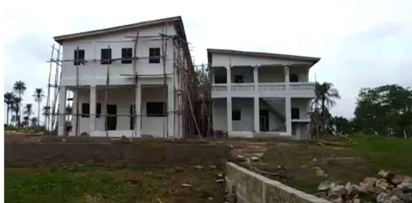
Der Rohbau beider Flügel ist fertiggestellt - Dez. 2019
