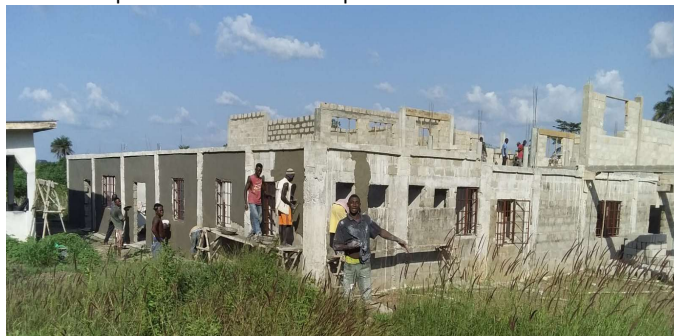
Das Erdgeschoss des Hauptgebäudes steht - Oktober 2019
