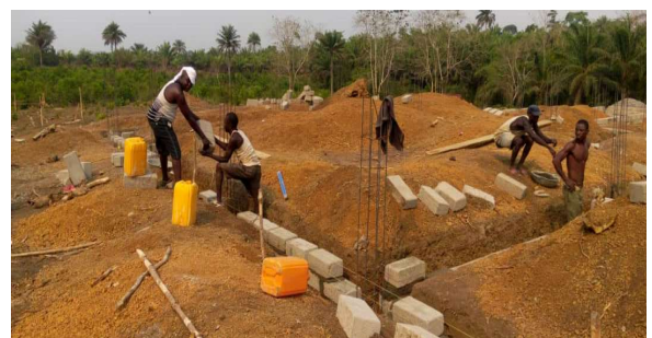
Verlegen der Fundamente – Januar 2019
