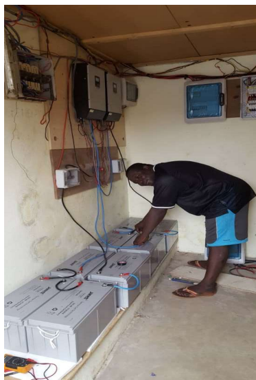
Der Photovoltaik-Kontrollraum mit Invertern und Batterien
