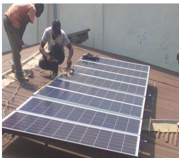
Installation der Paneele auf dem Dach der Gemeindebibliothek
