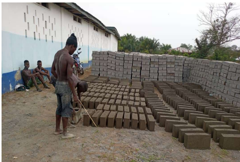
Praktikanten der Bauabteilung der neuen Berufsschule stellen Zementblöcke her
