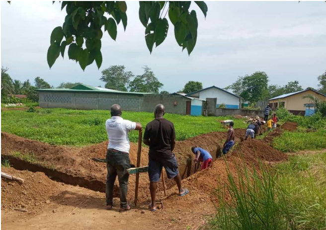
Ausheben der Fundamentgräben
