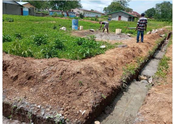
Gießen von Streifenfundamenten
