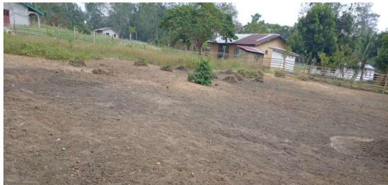
Das Freilegen des Spielplatzgeländes hat begonnen
