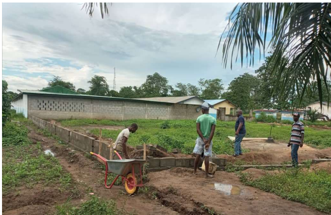
Beginn der Maurerarbeiten
