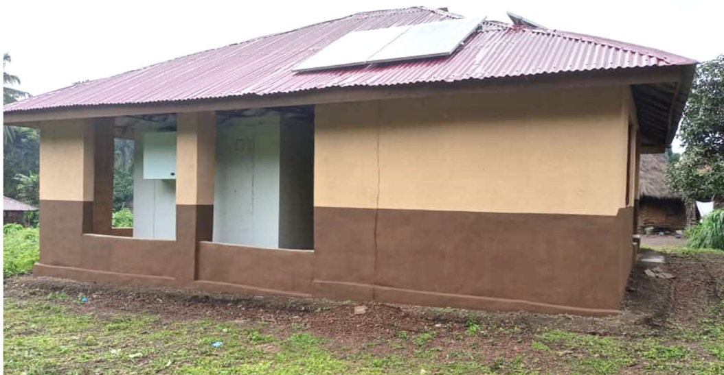
Ein typisches Kühlhaus mit hier (noch) 4 Solar-paneelen auf dem Dach. Links der Kühlraum mit Kühlaggregat, für gute Belüftung sorgen zwei große Maueröffnungen. Neben der Kühlmöglichkeit bietet die Anlage auch einen Community Enterprising Room mit Steckdosen zum Aufladen von Akkus, Handys, etc. Das Kühlhaus auf dem Foto steht im Dorf Najay im Chiefdom Kpanga im Distrikt Pujehun im Süden Sierra Leones.
