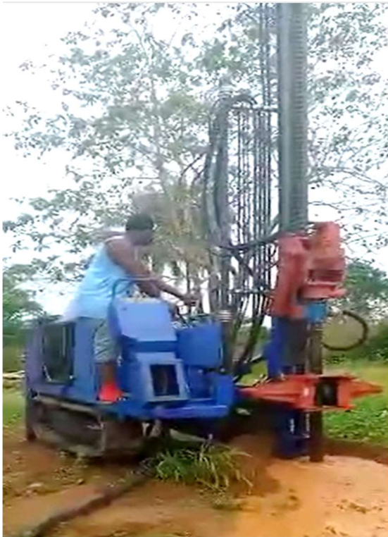
Brunnenbohrmaschine im Einsatz
