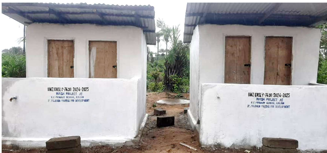
Und hier die neuen Spültoiletten der römisch-katholischen Grundschule in Bengani – ein Häuschen mit zwei Kabinen für Jungen, eines für Mädchen. Die Aufschrift nennt Projekt und Geldgeber.
