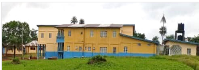
Hauptgebäude der Berufsschule in Pujehun, gebaut 2018-2020
