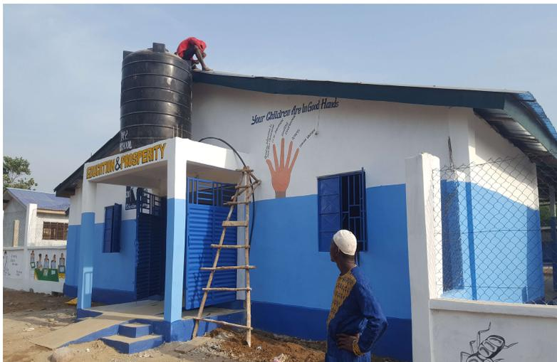
Zusätzlich wurden bis Dezember 2018 ein ca. 20 m tiefer Brunnen gebohrt, eine 1.000 kva Photovoltaik (PV)-Anlage und ein 5.000L Wassertank installiert und Strom- und Wasserleitungen verlegt. Für den Trinkwasserbrunnen und die PV-Anlage hat die VRD-Stiftung 5000 € bereitgestellt. Dafür sind KNLSL und PYD sehr dankbar!
